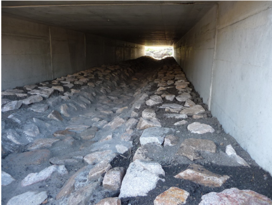
Abb. 12 Naturnaher Grabendurchlass mit seitlichen Bermen (Beispiel)
