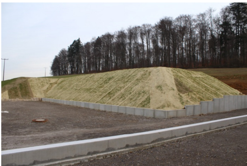
Foto 6 Einschnittsböschung neuer Sandreitplatz SO3 Zustand, 2018
