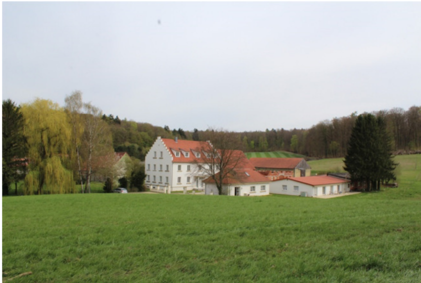
Foto 1 Wohn- und Nebengebäude Zustand, 2015
